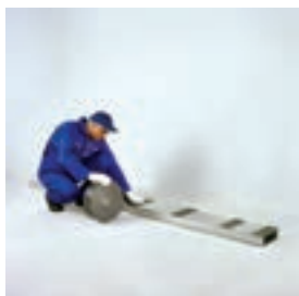
اجرای نوار عایق بر روی استاداها
