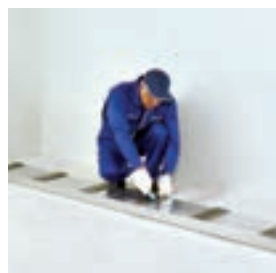
برش نوارهای عایق
