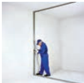
نصب استاد بر روی ساختار جانبی اتصال استاد به دیوار بنایی با رول پلاک اجرای استادهای (به صورت شاقولی)
