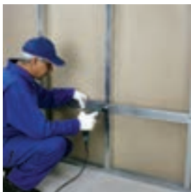
برای نصب پانل‌ها از پیچ مخصوص استفاده می‌شود نحوه صحیح در دست گرفتن پیچ گوشتی برقی اجرای پانل‌ها در یک طرف دیوار
