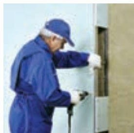
اجرای پانل ها در طرف دیگر دیوار
