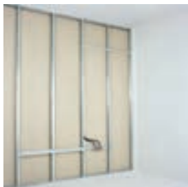
برای نصب پانل‌ها از پیچ مخصوص استفاده می‌شود نحوه صحیح در دست گرفتن پیچ گوشتی برقی اجرای پانل‌ها در یک طرف دیوار
