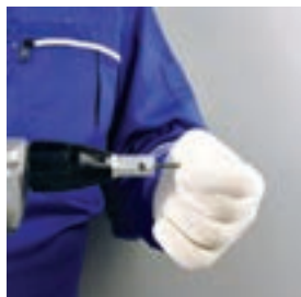
برای نصب پانل‌ها از پیچ مخصوص استفاده می‌شود نحوه صحیح در دست گرفتن پیچ گوشتی برقی اجرای پانل‌ها در یک طرف دیوار
