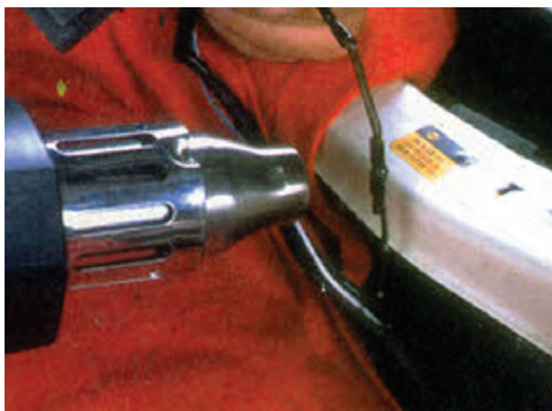
شکل ۱-۱۵۰- عایق کاری محل اتصال سیم ها
