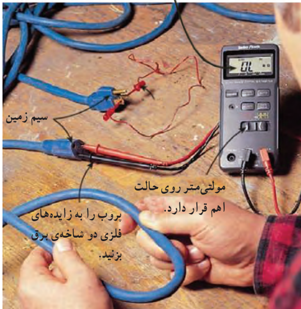
شکل ۲-۸۰ - آزمایش سیم رابط برق دستگاه.
