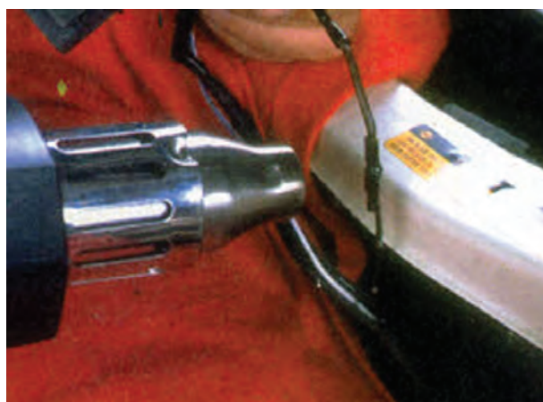
شکل ۱۵۰-۱- عایق کاری محل اتصال سیم ها
