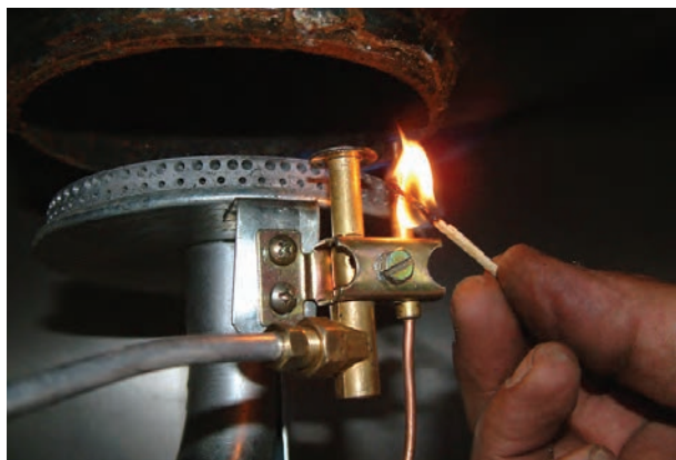
شکل ۱-۱۰۵- مشتعل کردن شمعی به وسیله‌ی شعله‌ی کبریت
