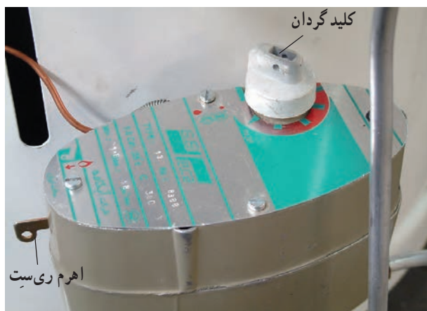
شکل ۱-۳۸- کاربرد اتور آب گرمکن نفت سوز
