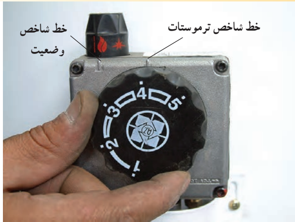
شکل ۱-۱۱۰- تغییر کلید تنظیم دما (ترموستات)
