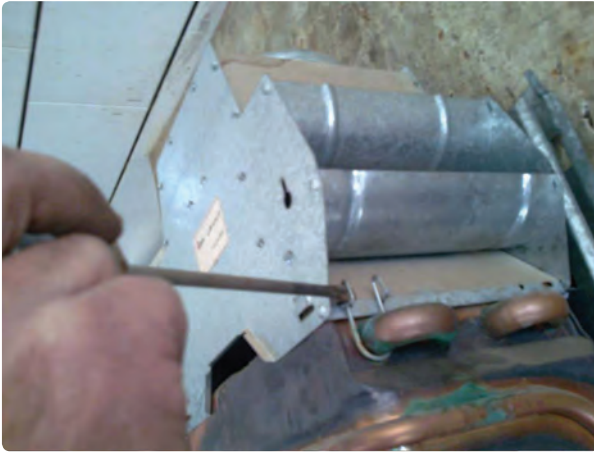
شکل ۶- جدا کردن کلاهک تعدیل از مبدل
