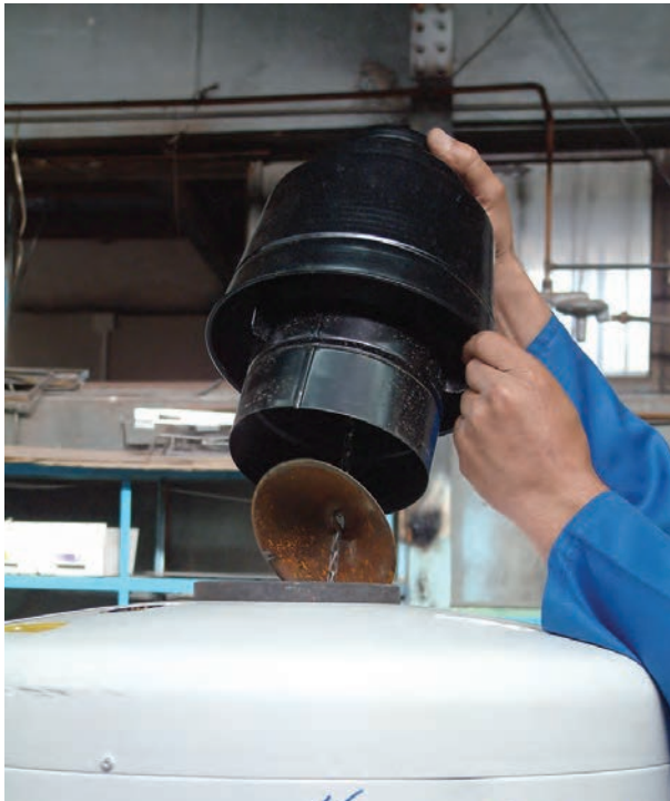
شکل ۱-۱۱۵- برداشتن کلاهک تعدیل از روی دودکش
