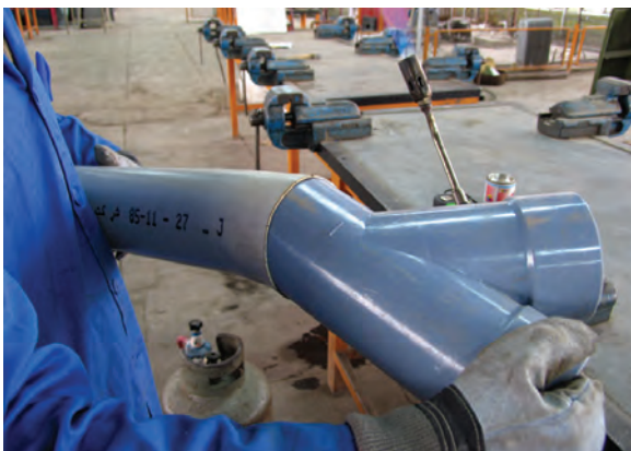
شکل ۲-۹- درست کردن سرکاسه
