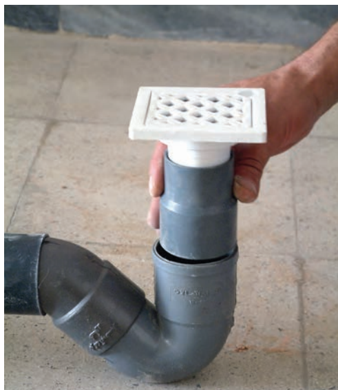
شکل ۳-۱۹- اتصال کف‌شوی به وسیله‌ی تبدیل
