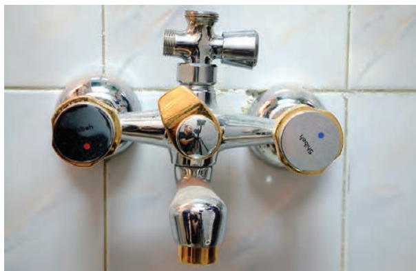
شکل ۲-۴۹ ب - سه راهی کمر تلفنی نصب شده بر روی شیر مخلوط دوش
