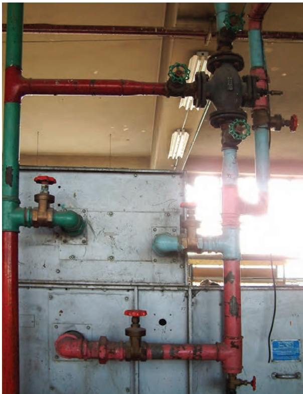
شکل ۲-۸۳ – مورد استفاده‌ی شیر فلکه در تهویه‌ی مطبوع
