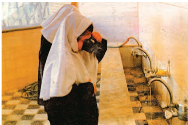
شکل ۲-۵۹- چکه کردن شیر آب
