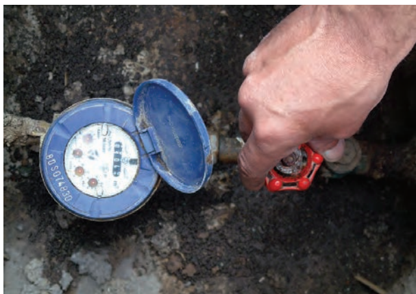
شکل ۲-۶۰ بستن شیر فلکه‌ی اصلی آب ساختمان
