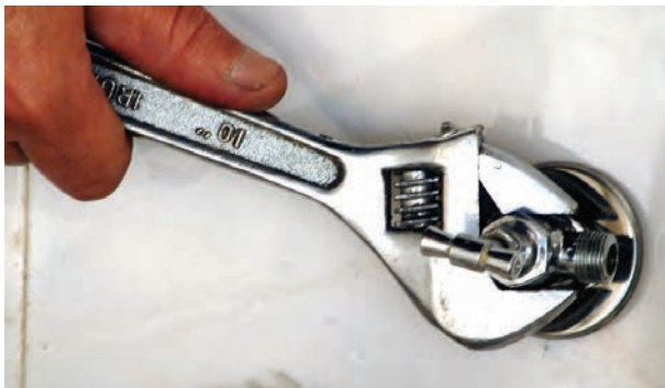
شکل ۱۴۴-۲- سفت کردن شیر پیسوار با آچار فرانسه
