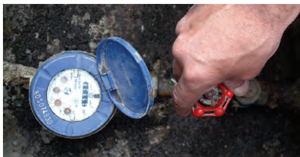
شکل ۱۴۰-۲ بستن شیر فلکه‌ی اصلی
