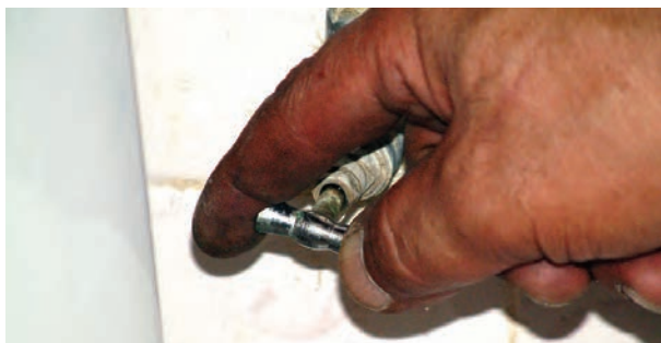
شکل ۱۴۶-۲- عمل هواگیری
