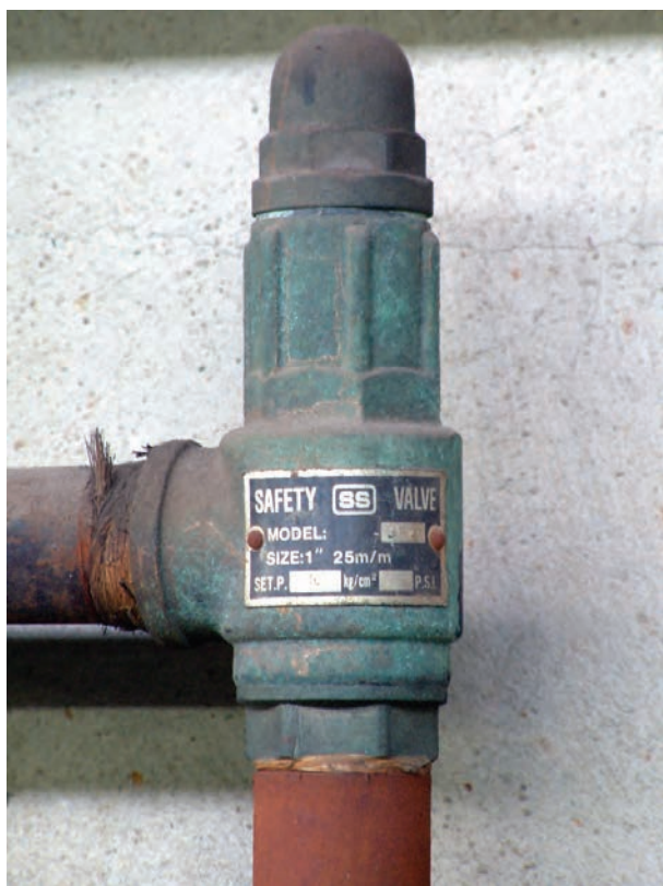
شکل ۲-۱۰۶- شیر اطمینان حساس در برابر فشار
