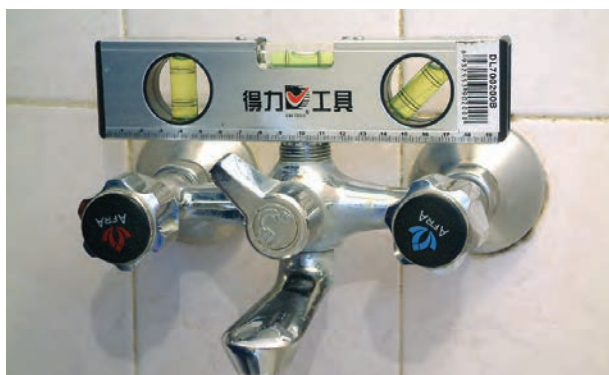
شکل ۲-۲۰۷- سنجش تراز بودن شیر مخلوط دوش
