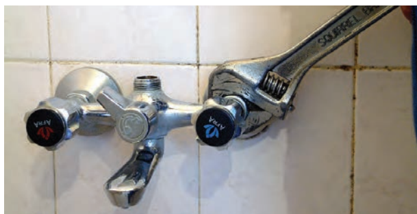
شکل ۲-۲۰۶- سفت کردن مهره‌های شیر با آچار
