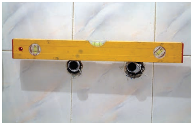
شکل ۲-۱۶۹- کنترل صاف بودن دنباله‌ها
