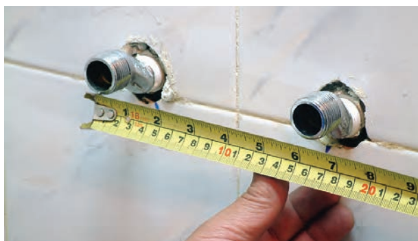
شکل ۱۶۸-۲ کنترل اندازه‌ی محور تا محور دنباله‌ها
