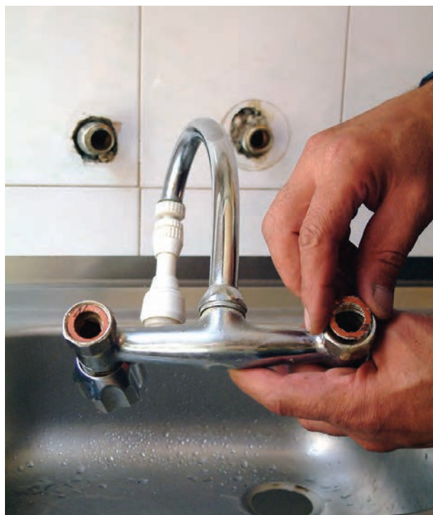
شکل ۲-۱۷۱- قراردادن واشر درون مهره‌ی تنه شیرمخلوط
