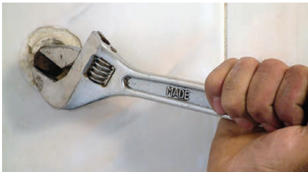
شکل ۲-۱۸۲- بازکردن درپوش‌ها
