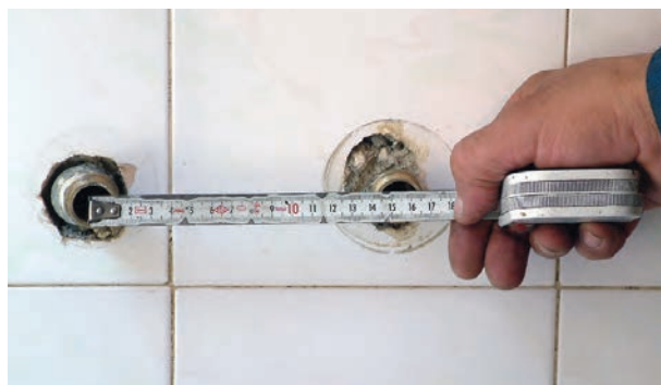
شکل ۲-۲۰۲- کنترل نمودن فاصله‌ی دنباله‌ها به وسیله‌ی متر
