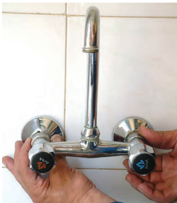
شکل ۱۷۲-۲ پیچیدن مهره‌ها به دنباله‌های شیر مخلوط
