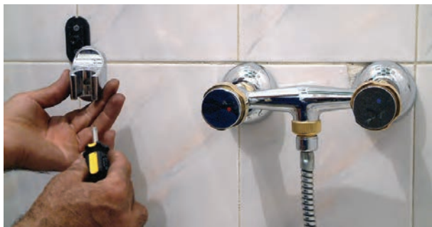
شکل ۱۹۴-۲- نصب بست آویز در محل خود
