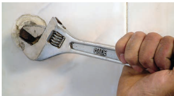
شکل ۱۹۸-۲- باز کردن درپوش‌ها
