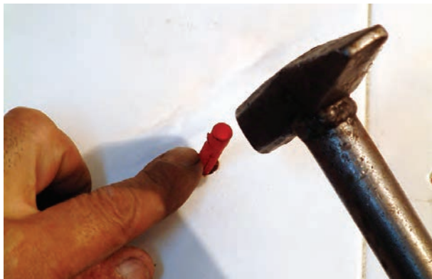
شکل ۱۹۳-۲- کوبیدن رولپلاک درون سوراخ
