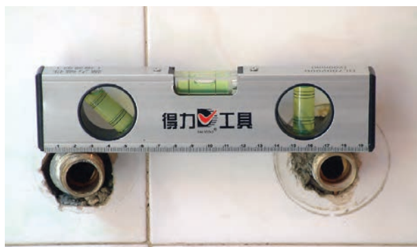
شکل ۲-۲۰۳- کنترل تراز بودن دنباله‌ها
