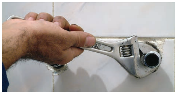
شکل ۱۶۷-۲ سفت کردن دنباله‌ها با آچار فرانسه
