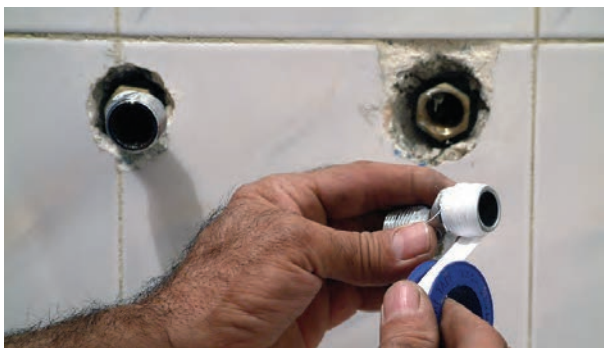
شکل ۲-۱۸۳- بیچیدن نوار تفلون به دنباله‌ها
