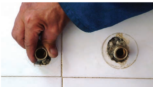
شکل ۲-۱۸۴- بیچیدن دنباله‌ها به محل نصب شیر
