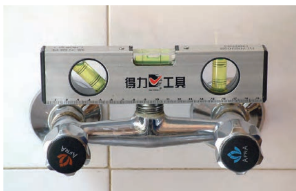
شکل ۱۷۴-۲ سنجش تراز بودن شیر مخلوط دیواری
