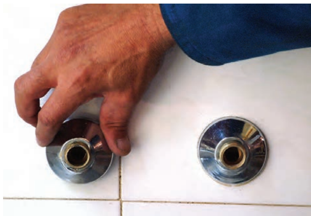
شکل ۲-۱۷۰- بستن کاسه‌ها به دنباله‌ها با دست
