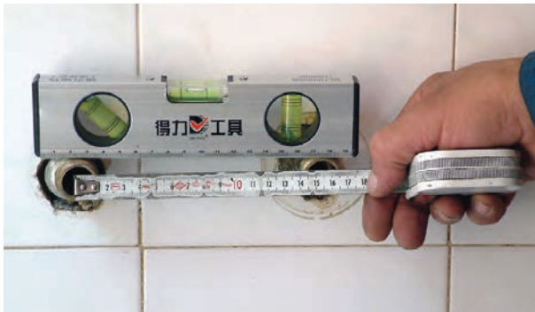
شکل ۲-۱۸۶- کنترل صاف بودن و اندازه‌ی دنباله‌ها
