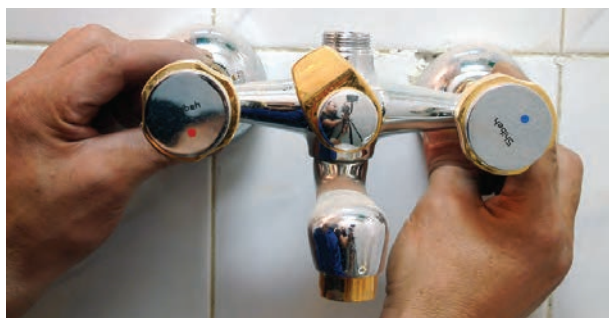
شکل ۲-۲۰۵- بستن مهره‌های شیر مخلوط دوش با دست
