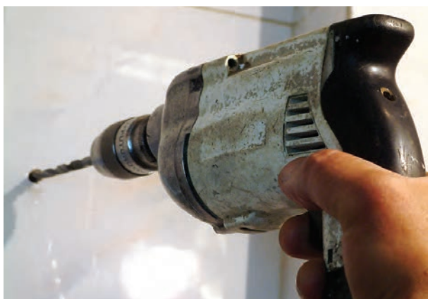
شکل ۱۹۲-۲- سوراخ کردن محل نصب بست آویز
