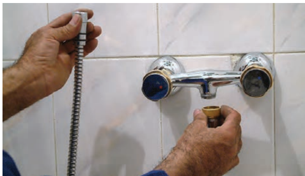
شکل ۱۹۱-۲- اتصال شیلنگ آفتابه به شیر مخلوط توالت
