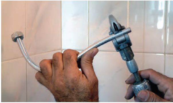
شکل ۲۲۲-۳- بریدن لوله‌ی پیسوار به وسیله‌ی لوله‌بر
