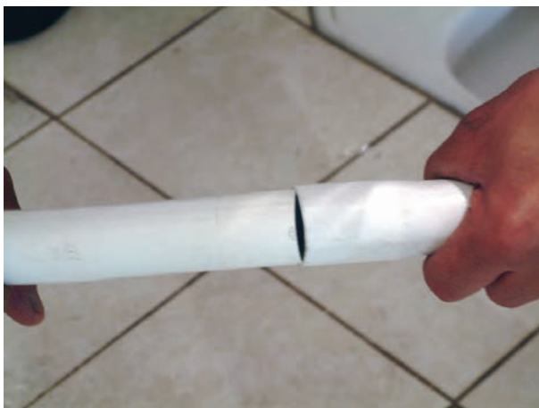
شکل ۲۰۶-۳- جا زدن لوله‌های تخلیه در درون یکدیگر
