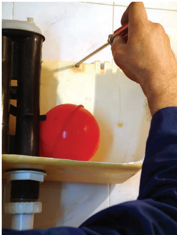
شکل ۲۱۳-۳- نصب مخزن فشاری به دیوار
