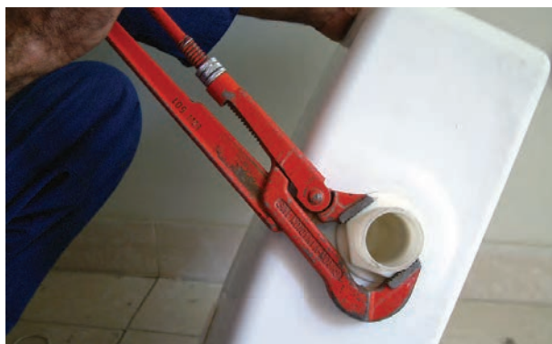
شکل ۳-۲۰۸- سفت کردن مهره‌ی پمپ تخلیه
