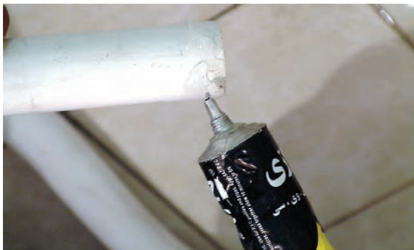
شکل ۲۰۵-۳- زدن چسب به لوله‌های تخلیه
