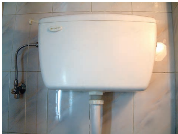
نصب مخزن فشاری
