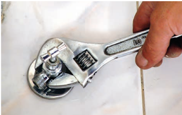
شکل ۲۲۰-۳- سفت کردن شیر پیسوار با آچار فرانسه
