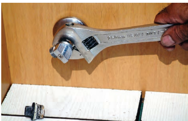
شکل ۳-۲۵۴- سفت کردن شیر پیسوار
