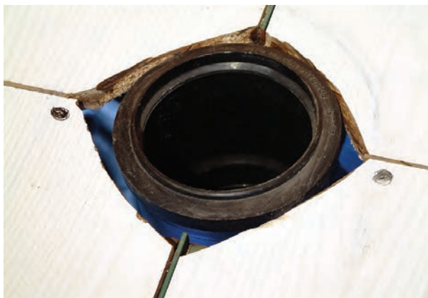
شکل ۲۴۴-۳- قرار دادن بوگیر در داخل زانویی
