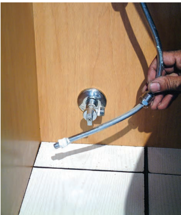
شکل ۳-۲۵۵- خمکاری لوله‌ی پیسوار
