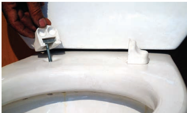
شکل ۳-۲۵۳- اتصال بست‌های نگهدارنده به توالت فرنگی
