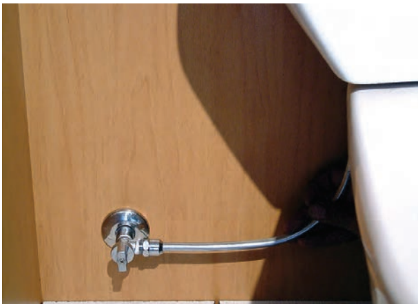
شکل ۳-۲۵۷- اتصال لوله‌ی پیسوار و باز کردن شیر پیسوار
