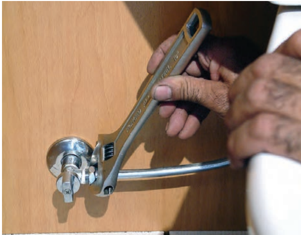
شکل ۳-۲۵۶- سفت کردن مهره‌ی شیر پیسوار
