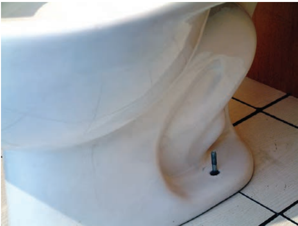
شکل ۲۴۸-۳- قرار دادن توالت فرنگی در محل خود
