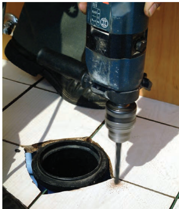
شکل ۲۴۶-۳- سوراخ کاری محل‌های علامت گذاری شده
