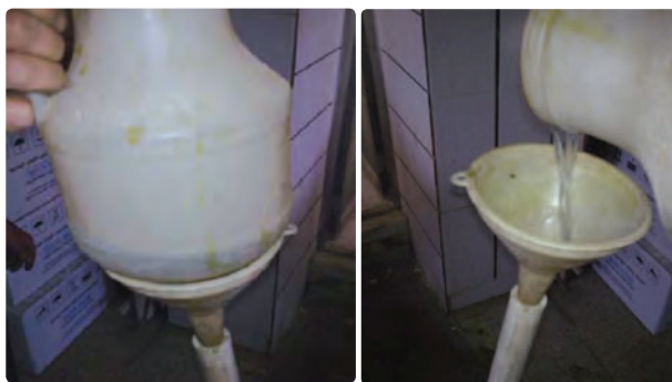
شکل ۱۸- شست و شوی مبدل بعد از رسوب‌زدایی
