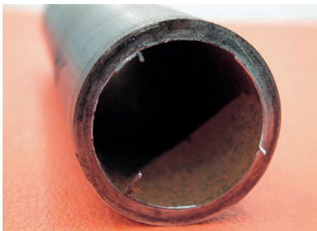
الف - لوله‌ی بریده شده به وسیله‌ی لوله‌بر
