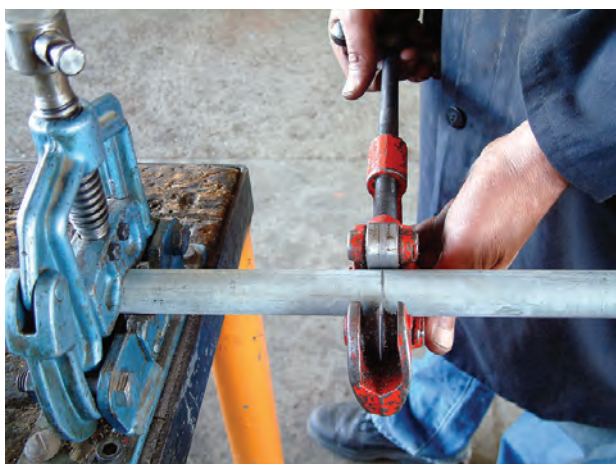
شکل ۱-۶۲- سفت کردن دسته‌ی لوله‌بر به اندازه‌ی لازم
