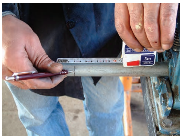
شکل ۱-۷- علامت‌گذاری کردن لوله با متر و مداد
