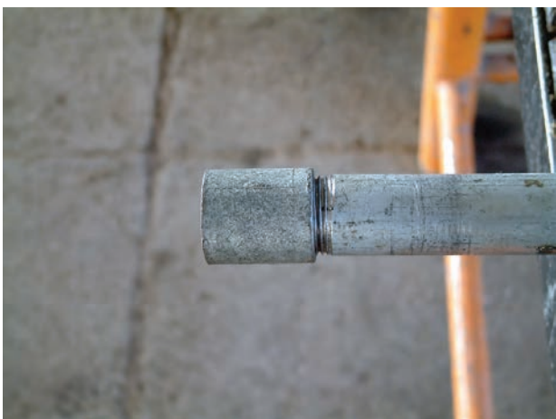
شکل ۴-۱۵ اتصال بوشن فلزی بدون لبه به سردنده‌ی لوله
