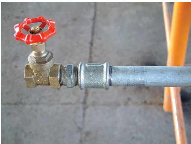
شکل ۴-۸- اتصال دنده‌ای
