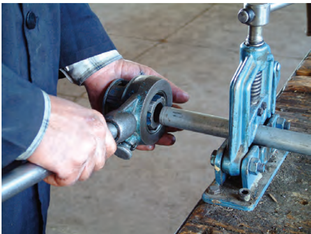
شکل ۴-۴۵- شروع حدیده کاری
