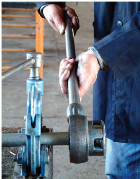
شکل ۴-۵۰- باز کردن حدیده از لوله
