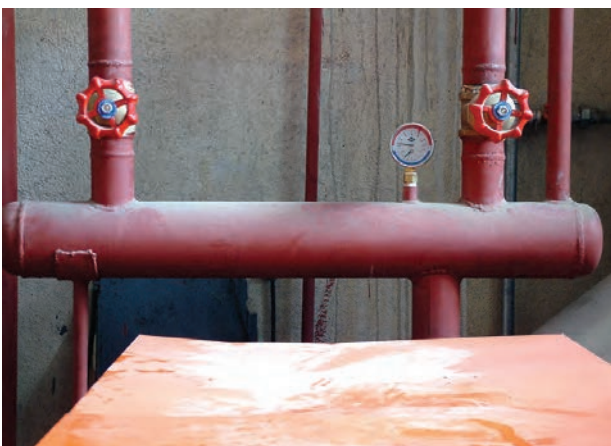
شکل ۳-۵- استفاده از اتصال جوشی در حرارت مرکزی
