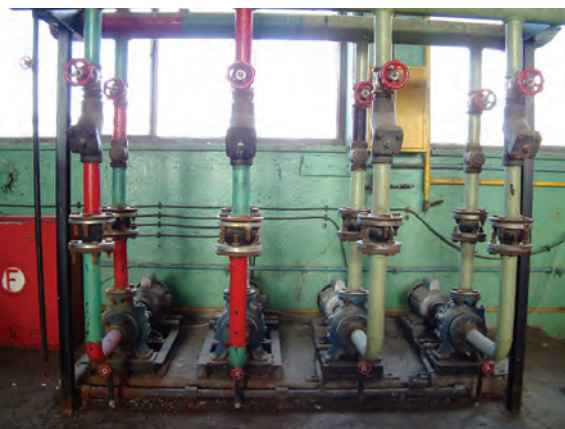
شکل ۳-۵- کاربرد لوله درزدار در لوله‌کشی شوفاز
