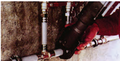
شکل ۲۳-۵ - اتصال پرسی
