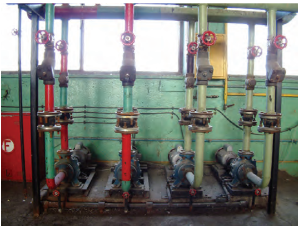
شکل ۳-۵- استفاده از اتصال فلنجی برای نصب پمپ‌های زمینی در تهویه مطبوع
