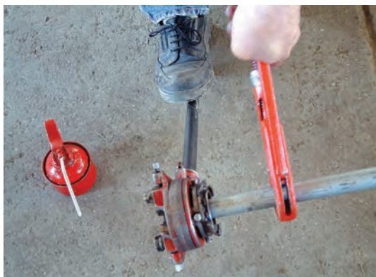
شکل ۱۲۰-۵- عمل حدیده کاری لوله
