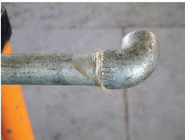
شکل ۹۸-۵- فیتینگ بدون لبه
