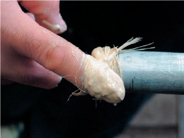
شکل ۹۰-۵- خمیر و کنف کردن سردنده
