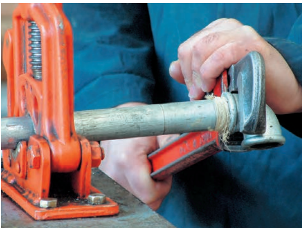
شکل ۹۲-۵- سفت کردن فیتینگ به وسیله‌ی آچار لوله‌گیر
