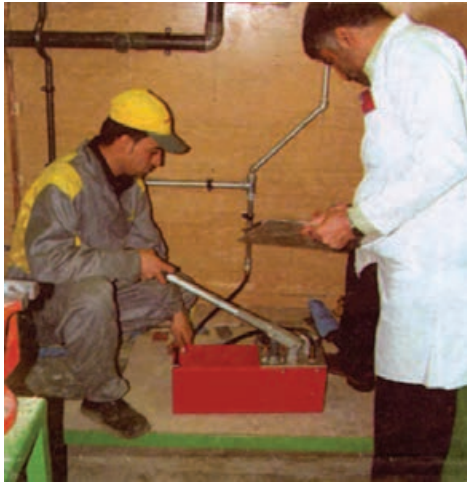
شکل ۵-۹۳- نحوه‌ی آزمایش با پمپ آزمایش دستی
