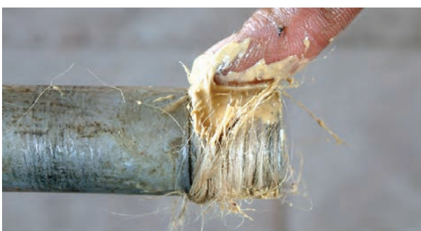
شکل ۵-۵۷- مالیدن خمیر آب بندی بر روی کنف
