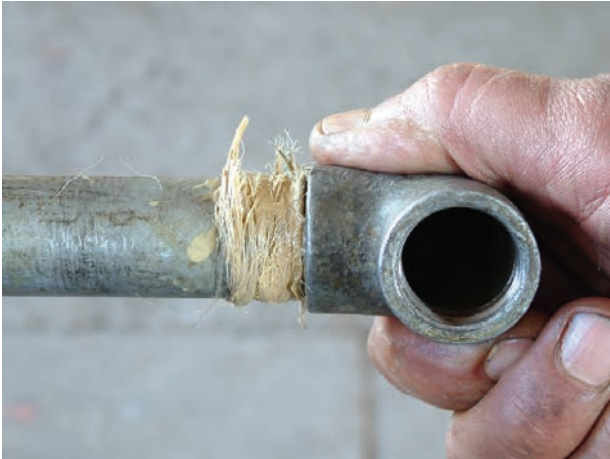
شکل ۹۱-۵- بستن فیتینگ بر روی سردنده
