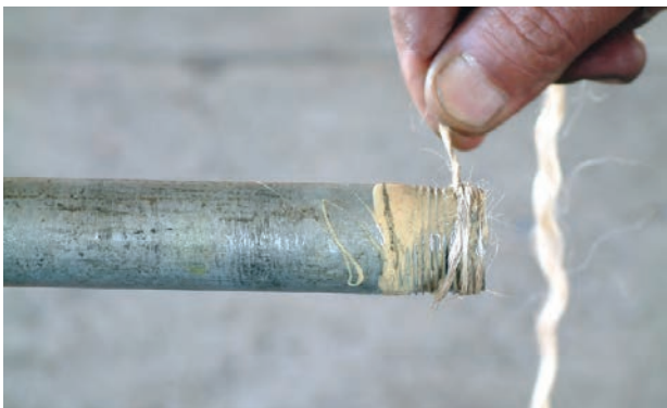
شکل ۵-۵۴- پیچیدن کنف بر روی سردنده
