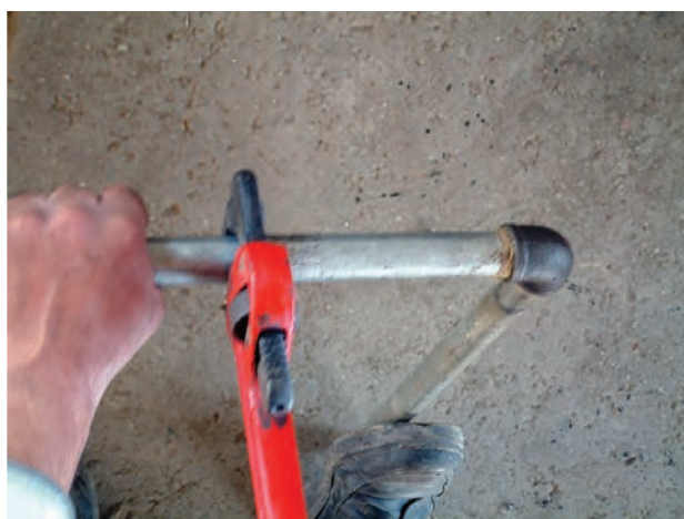
شکل ۱۲۶-۵- سفت کردن لوله به فیتینگ به وسیله‌ی یک عدد آچار لوله‌گیر
