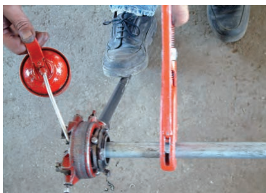
شکل ۱۲۱-۵- استفاده از روغن در جریان حدیده کاری
