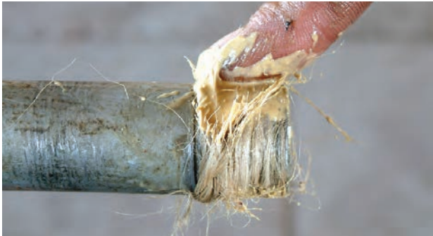
شکل ۵-۱۰۰- استفاده از مواد آب‌بندی
