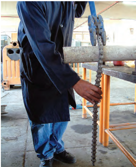
شکل ۶۸-۵- استفاده از آچار زنجیری برای کاربر روی لوله‌های قطور
