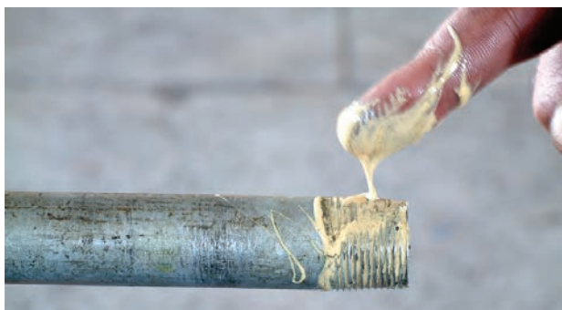
شکل ۵-۵۳- مالیدن خمیر بر روی سردنده
