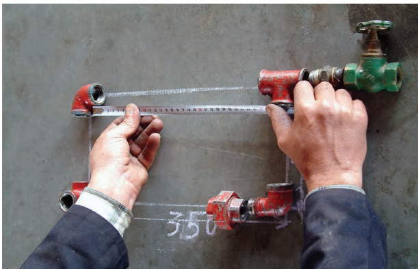
شکل ۱۴۹-۵- اندازه گیری طول لوله ها
