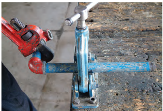
شکل ۵-۱۵۴- بستن لوله‌ی ضلع دوم مدار
