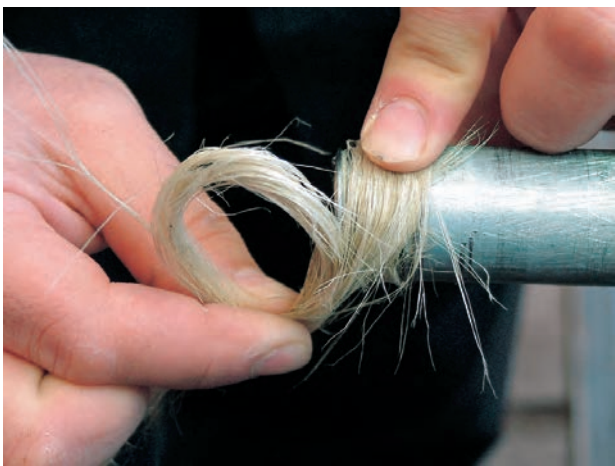
شکل ۱۳۸-۵- پیچیدن مواد آب‌بندی به سردنده‌ها
