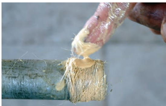
شکل ۵-۱۵۲- خمیر و کنف کردن سردنده‌ها
