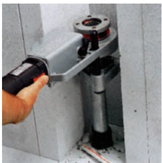
شکل ۴-۱۰۵ - طرز استفاده از حديدى
