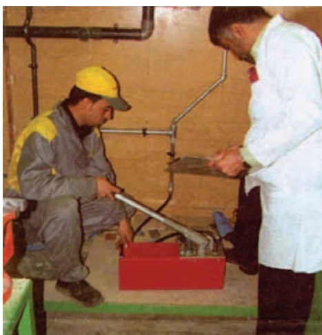
شکل ۵-۹۳- نحوه‌ی آزمایش با پمپ آزمایش دستی
