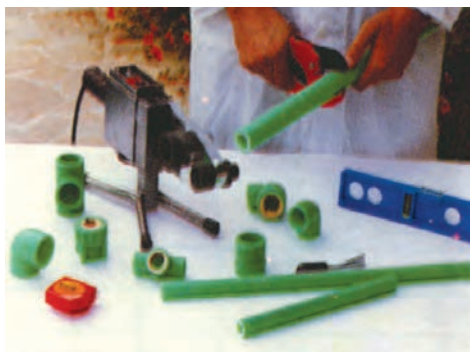
شکل ۵-۲۷ - بریدن لوله به وسیله‌ی قیچی مخصوص
