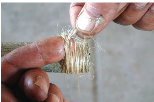
شکل ۵-۵۵- گره زدن انتهای پیچیدن کنف
