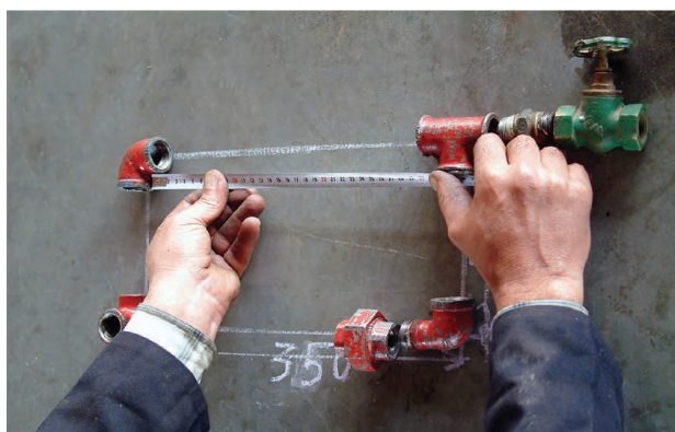
شکل ۱۴۹-۵ اندازه گیری طول لوله ها
