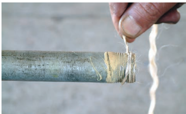
شکل ۵-۵۴- پیچیدن کنف بر روی سردنده
