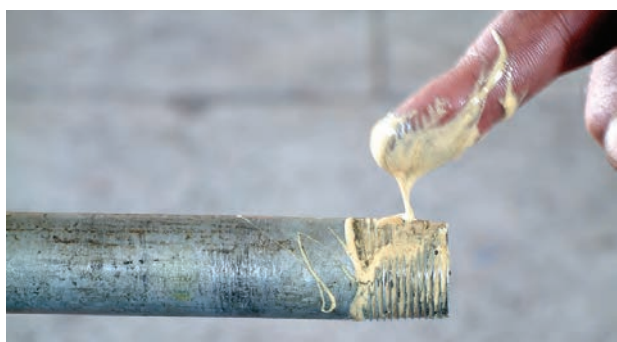
شکل ۵-۵۳- مالیدن خمیر بر روی سردنده
