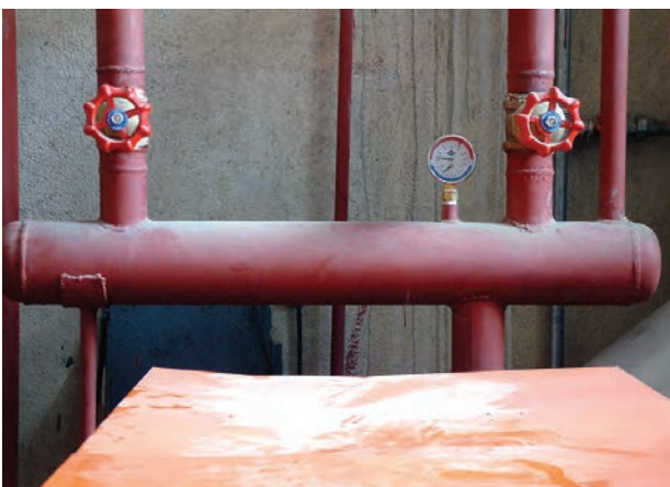
شکل ۳-۵- استفاده از اتصال جوشی در حرارت مرکزی
