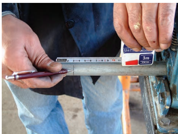
شکل ۷۰-۱ علامت‌گذاری کردن لوله با متر و مداد
