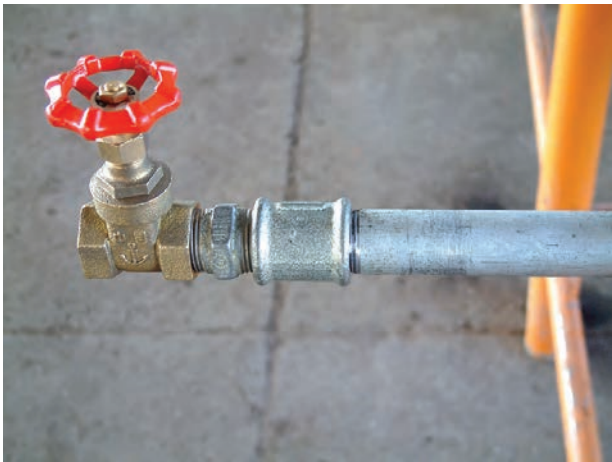
شکل ۴-۸- اتصال دنده‌ای
