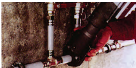
شکل ۵-۲۳ - اتصال پرس
