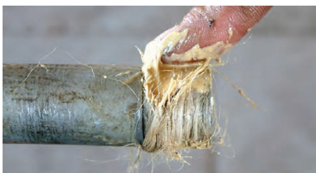
شکل ۵-۵۷- مالیدن خمیر آب بندی بر روی کنف
