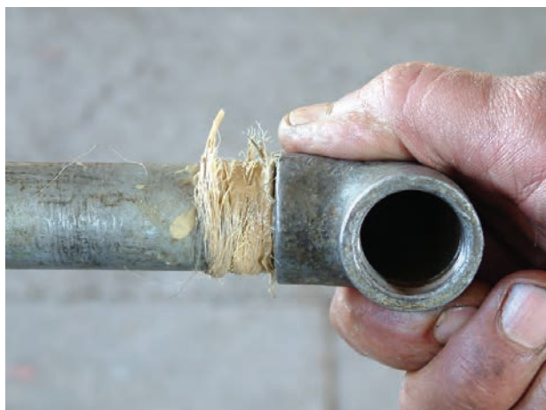
شکل ۵-۹۱- بستن فیتینگ بر روی سردنده
