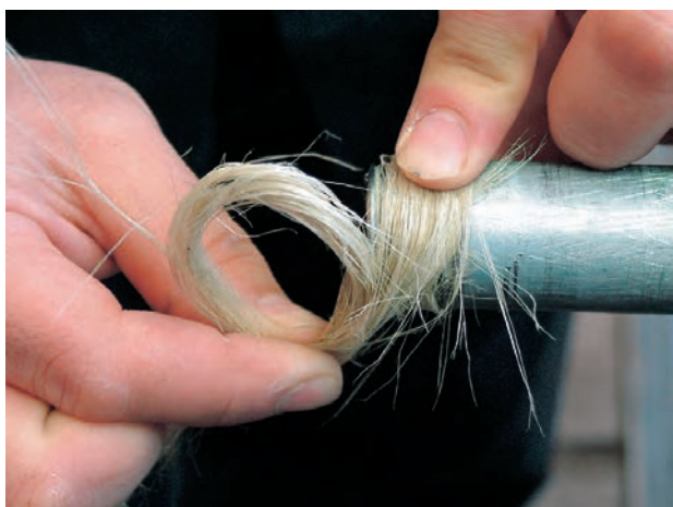
شکل ۵-۱۳۸- پیچیدن مواد آب‌بندی به سردنده‌ها
