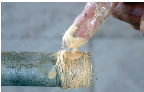
شکل ۵-۱۵۲- خمیر و کنف کردن سردنده‌ها
