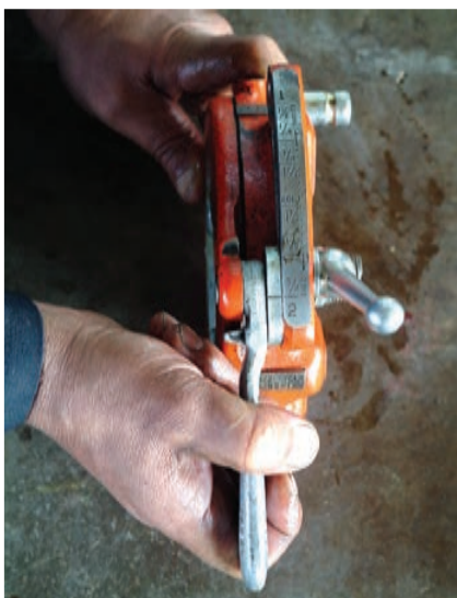
شکل ۴-۹۳- تنظیم حدیده به اندازه‌ی لوله‌ی ۲ اینچ
