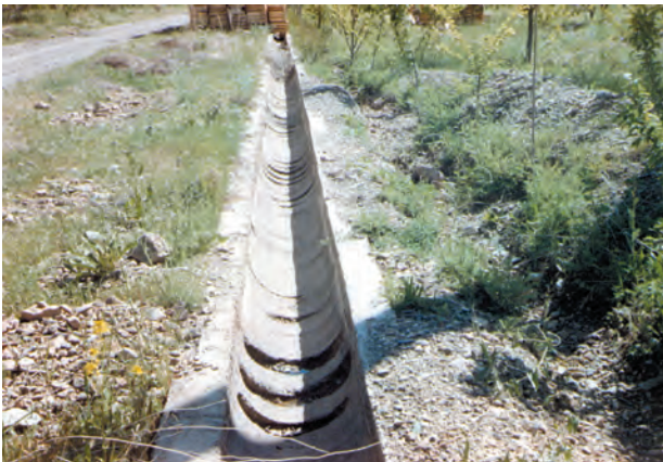
شکل ۲-۲- کانال با مقطع دوزنقه‌ای
