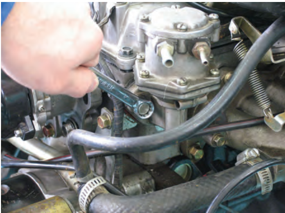
شکل ۴۲-۱ پیاده کردن پمپ
