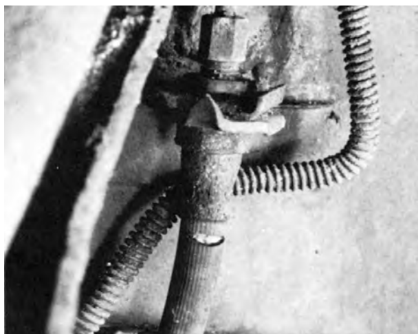
شکل ۱-۶۹- کنترل لوله‌ها و اتصالات
