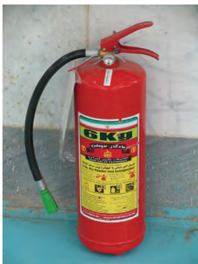
شکل ۱-۲۲ کپسول آتش‌نشانی استاندارد
