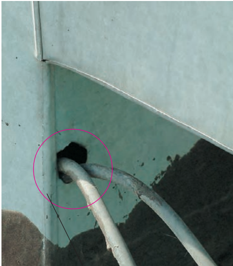
کابل‌کشی در داخل کانال کولر
