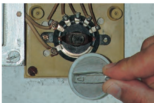
شکل ۷-۳۷۶ سیم رابط فاز خروجی کلید به پهنکه
