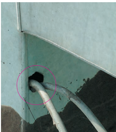
کابل‌کشی در داخل کانال کولر
