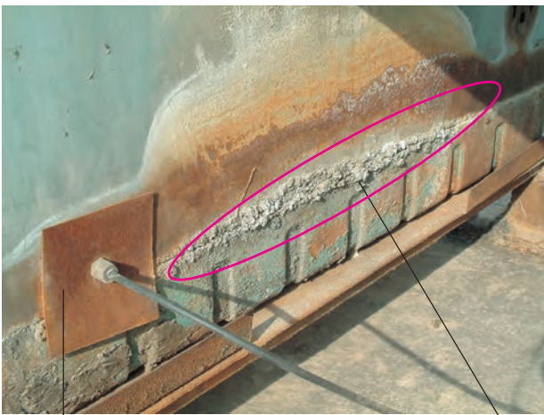
رسوب‌های آب تعمیر غیراساسی شکل ۸-۱۷۶
