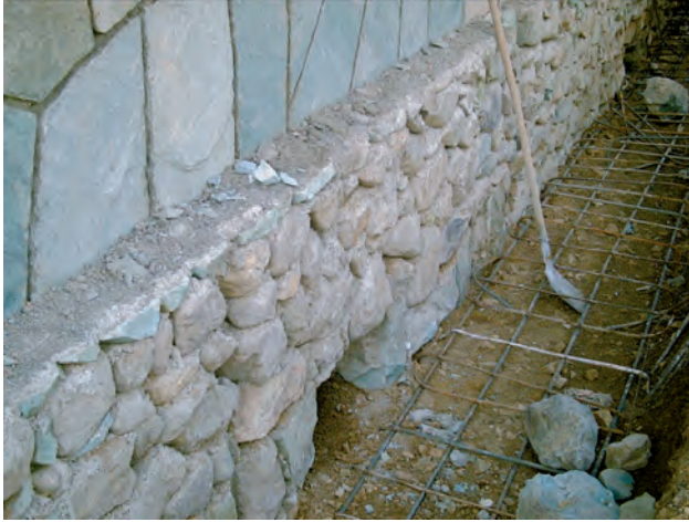
تصویر ۱- پی و دیوار سنگی
