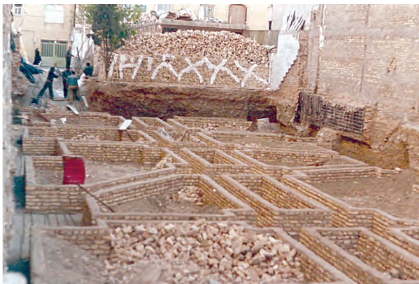
تصویر ۵ - قالب بندی آجری بی ساختمان
