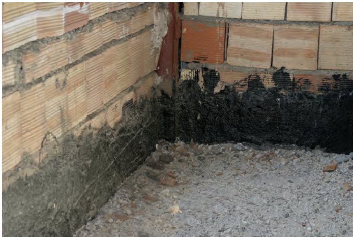
تصویر ۱۶ - عایق کاری کف سرویس بهداشتی
