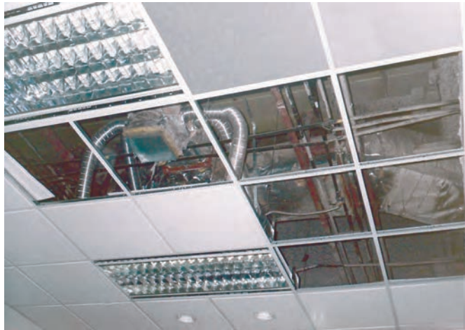
تصویر ۲۰- زیر سازی سقف کاذب
