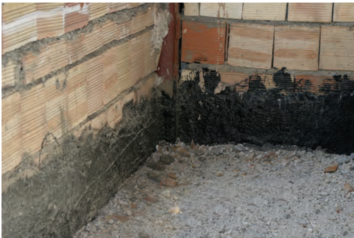
تصویر ۱۶ - عایق کاری کف سرویس بهداشتی
