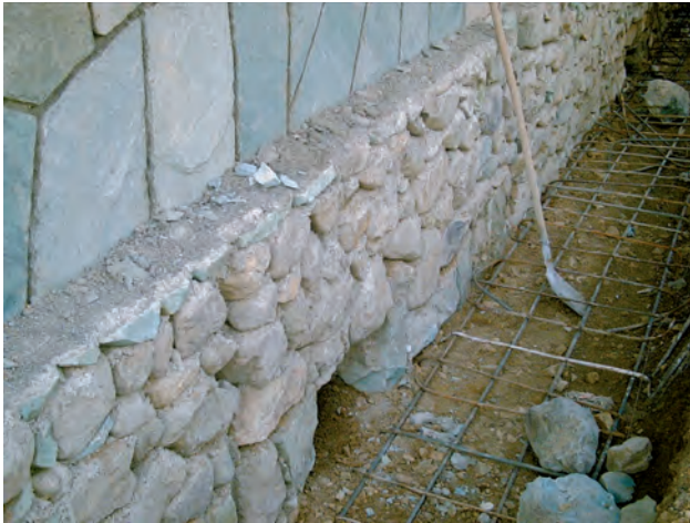
تصویر ۱- پی و دیوار سنگی
