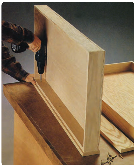
شکل ۴۰- کاربرد تخته سه‌لایه در کف جعبه
