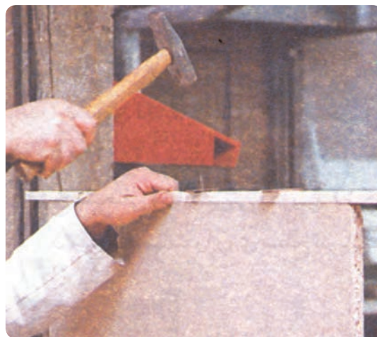
شکل ۶-۷۸ نصب زهوار چوبی لبه چسبان
