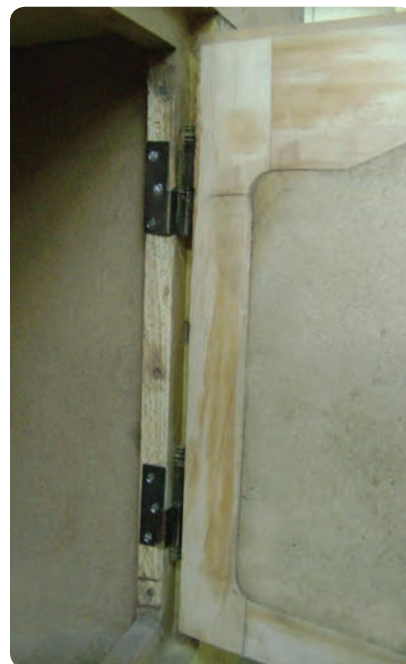
شکل ۶-۸۸ در قاب تنکه‌ای با لولای قابل‌مهم‌ای
