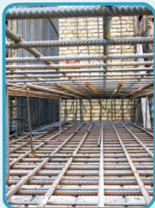
شکل ۱۵-۱- فولاد در بتن
