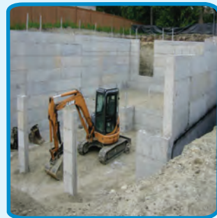
شکل ۲۱-۲- دیوار باربر
