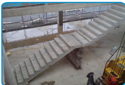
شکل ۳۷-۲- نمونه‌هایی از پله‌های بتنی
