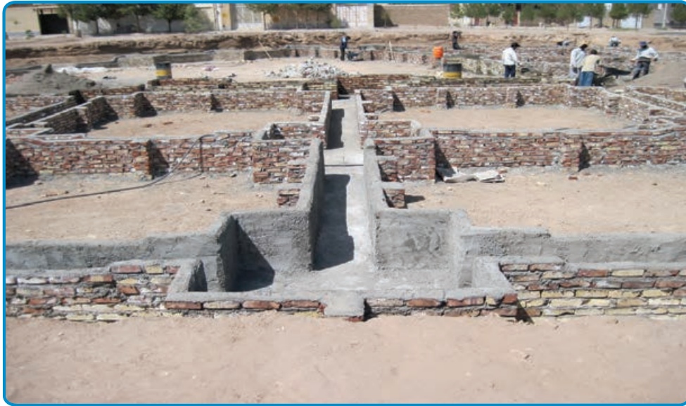
شکل ۳-۲۹- قالب آجری برای اجرای پی
