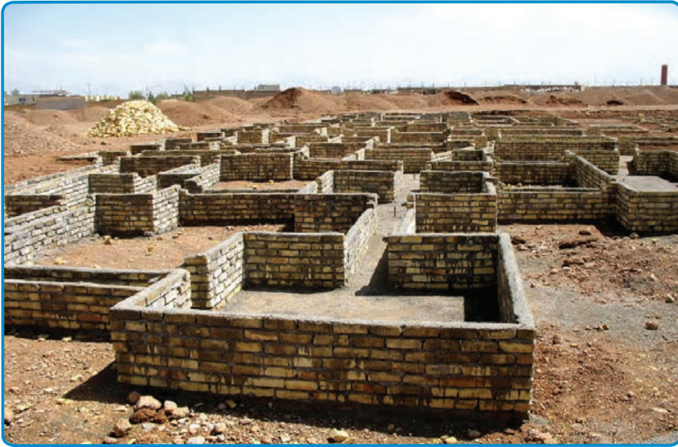
شکل ۱۵-۳- استفاده از قالب آجری برای اجرای پی
