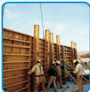
شکل ۳-۳۶- قالب فایبر گلاس برای اجرای دیوار بتنی
