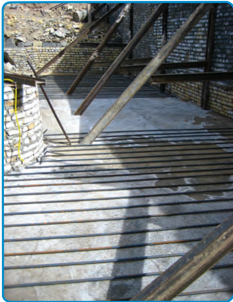
شکل ۳-۴۶- میلگرد طولی کف پی
