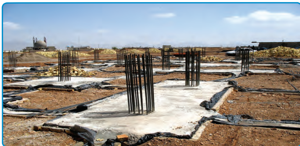
شکل ۱۰-۳- استفاده از پلاستیک در پی
