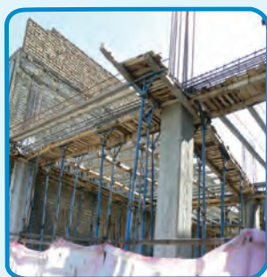
شکل ۳-۳۹- استفاده از قالب چوبی برای اجرای تیر
