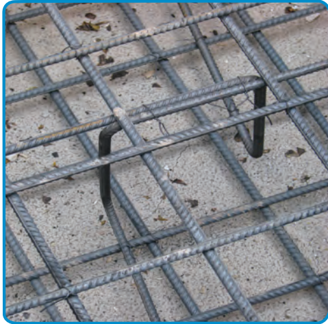
شکل ۳-۵۳- استفاده از خرک در میلگرد گذاری پی
