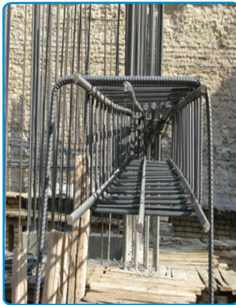
شکل ۳-۴۵- میلگرد طولی در تیر
