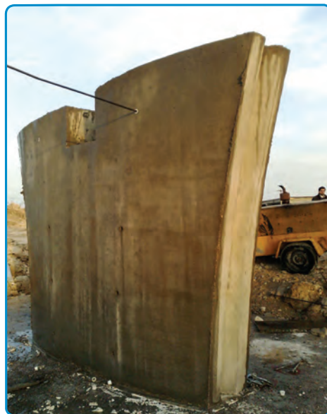
شکل ۳-۴۲- قالب برداری
