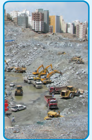
شکل ۳-۷- گودبرداری در زمین‌های نامحدود
