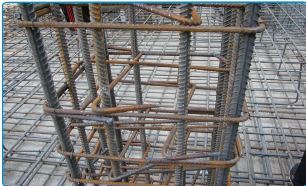
شکل ۵۰-۳- کاربرد سنجاقک در میلگرد گذاری ستون
