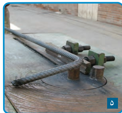
شکل ۳-۶۴ - خم کردن میلگرد
