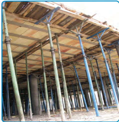
شکل ۳-۲۱- استفاده از شمع‌های فلزی جهت نگهداری قالب‌ها
