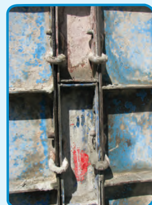
شکل ۱۳-۳- پشت بند قالب
