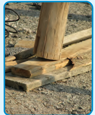
شکل ۳-۲۵- استفاده از گوه جهت تنظیم ارتفاع
