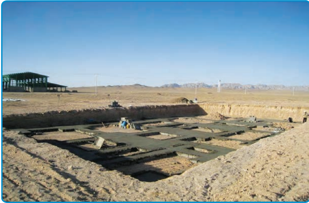
شکل ۳-۶- گودبرداری در زمین‌های نامحدود
