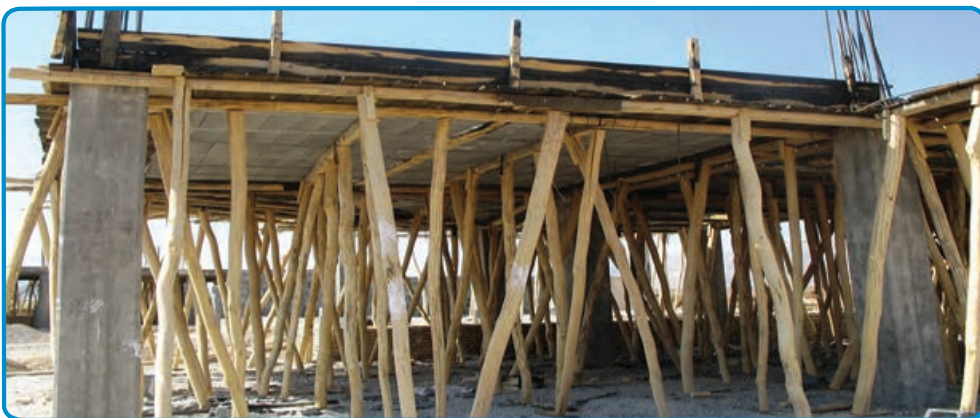
شکل ۳-۲۴- استفاده از شمع‌های چوبی جهت نگهداری قالب‌ها
