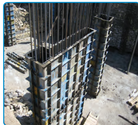
شکل ۳-۳۵- قالب فلزی برای اجرای دیوار بتنی
