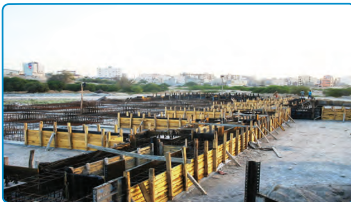
شکل ۳-۲۷- قالب چوبی برای اجرای پی
