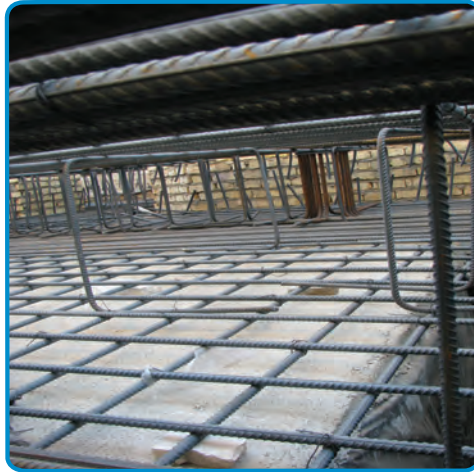
شکل ۳-۵۳- استفاده از خرک در میلگرد گذاری پی
