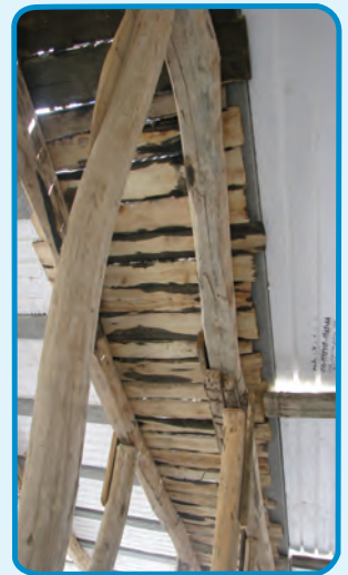
شکل ۱۶-۳- استفاده از قالب چوبی برای اجرای تیر بتنی
