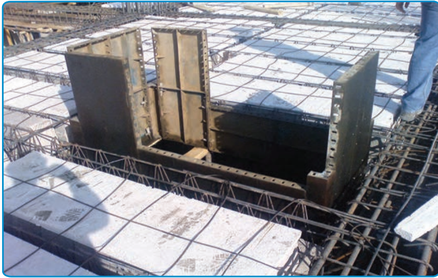
شکل ۳۵-۷- تکمیل قالب بندی
