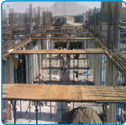
شکل ۷-۲۱- قالب بندی تیرها
