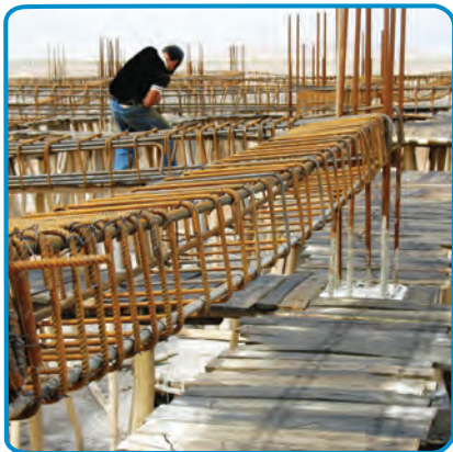
شکل ۷-۲۴- تنظیم فاصله بین خاموت ها
