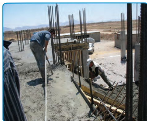
شکل ۴۲-۷- بتن ریزی دال پله
