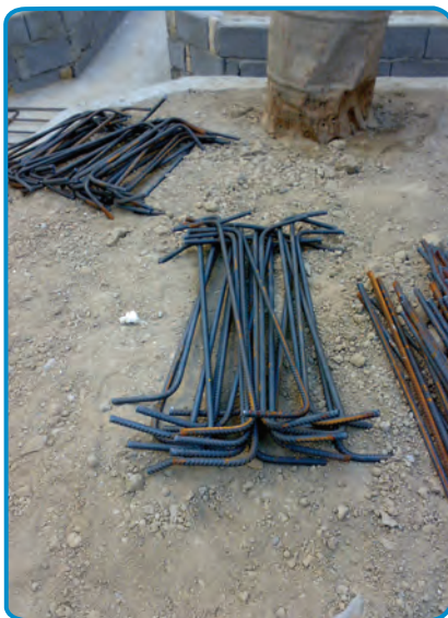
شکل ۷-۷- آماده کردن میلگردهای طولی و عرضی
