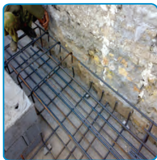
شکل ۱۲-۷- میلگردگذاری شبکه بالای
