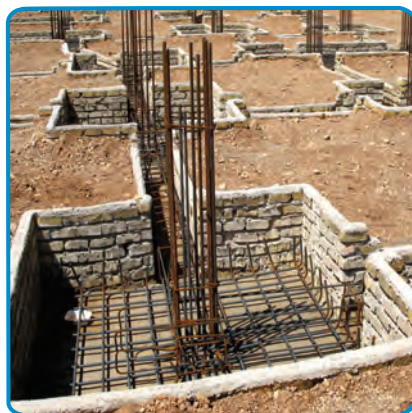
شکل ۴-۷- اجرای میلگردهای ریشه انتظار
