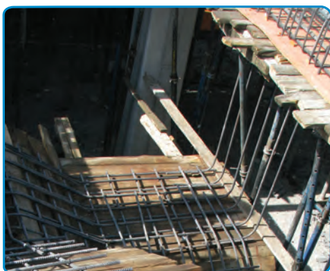
شکل ۴۱-۷- اجرای میلگردهای دال پله
