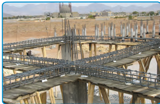
شکل ۷-۲۷- رعایت فاصله پوشش بتنی در کف
