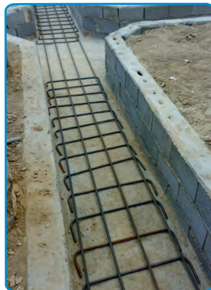
شکل ۸-۷- چیندن میلگردهای طولی و عرضی
