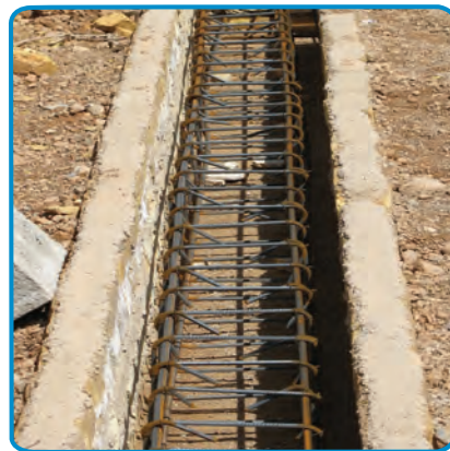
شکل ۵-۷- اجرای میلگرد شناژها
