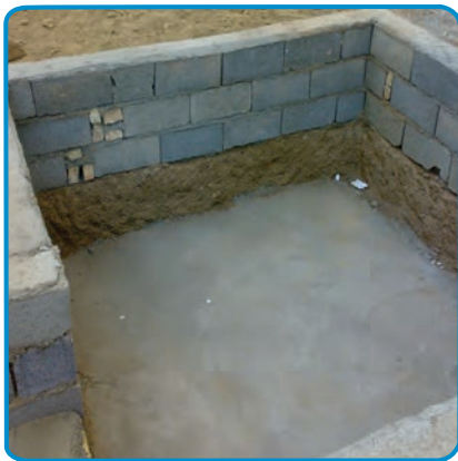
شکل ۱-۷- آماده سازی کف پی
