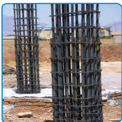
شکل ۱۶-۷- بتن ریزی ستون
