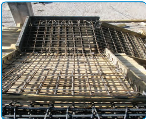
شکل ۳۷-۷- اجرای میلگردهای دال پله
