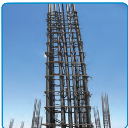
شکل ۱۹-۷- کار گذاشتن میلگردهای انتظار ستون، در فونداسیون
