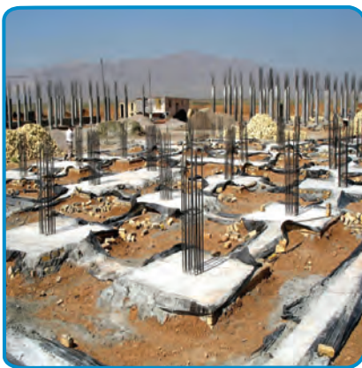
شکل ۱۷-۷- اجرای خاموت و سنجاقک
