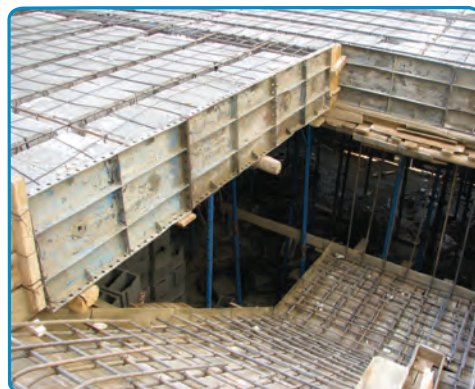
شکل ۴۰-۷- اجرای میلگردهای دال پله
