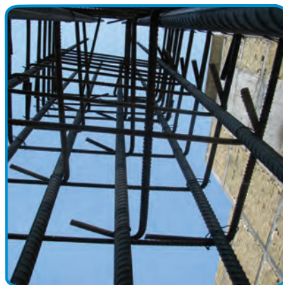
شکل ۱۹-۷- کار گذاشتن میلگردهای انتظار ستون، در فونداسیون
