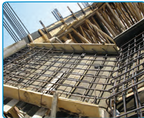
شکل ۳۸-۷- اجرای میلگردهای دال پله
