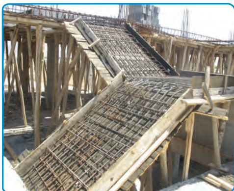
شکل ۳۹-۷- اجرای میلگردهای دال پله
