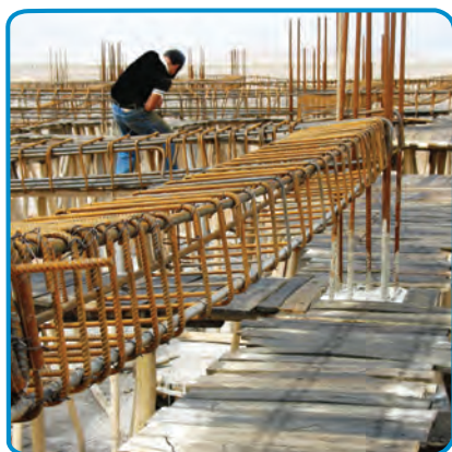
شکل ۷-۲۴- تنظیم فاصله بین خاموت ها
