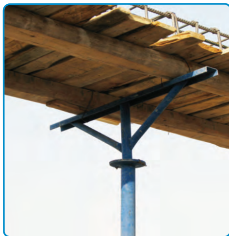
شکل ۳-۲۱- استفاده از شمع‌های فلزی جهت نگهداری قالب‌ها
