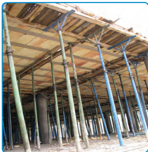
شکل ۳-۲۱- استفاده از شمع‌های فلزی جهت نگهداری قالب‌ها
