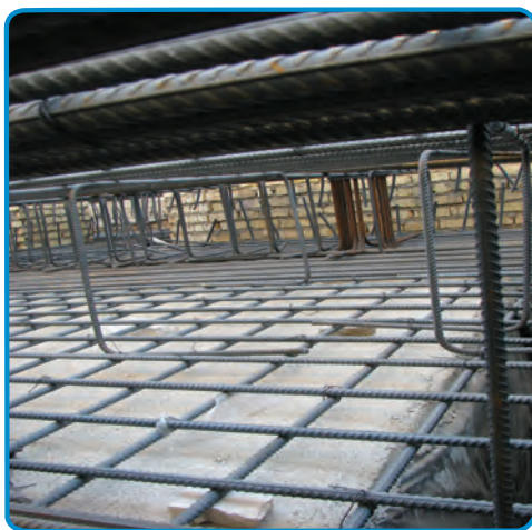
شکل ۳-۵۳- استفاده از خرک در میلگرد گذاری پی
