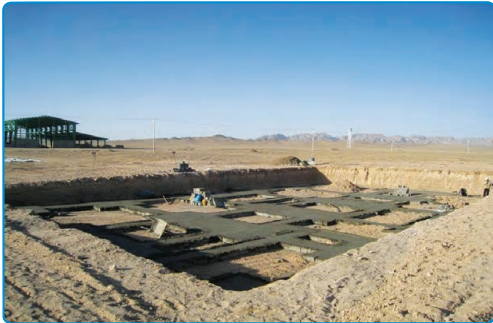
شکل ۳-۶- گودبرداری در زمین‌های نامحدود
