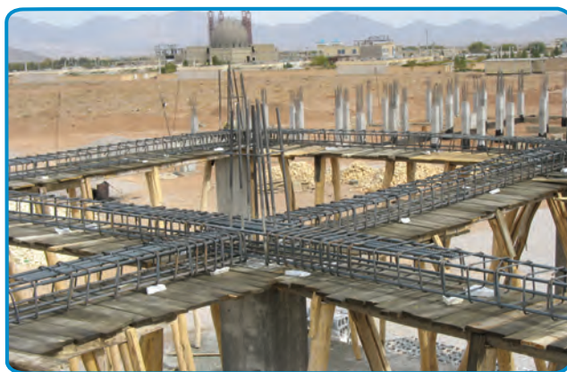
شکل ۷-۲۷- رعایت فاصله پوشش بتنی در کف
