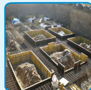
شکل ۳-۳۱- قالب فایبرگلاس برای اجرای پی
