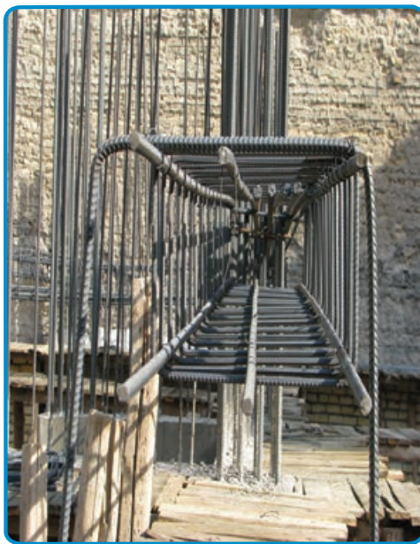
شکل ۳-۴۵- میلگرد طولی در تیر
