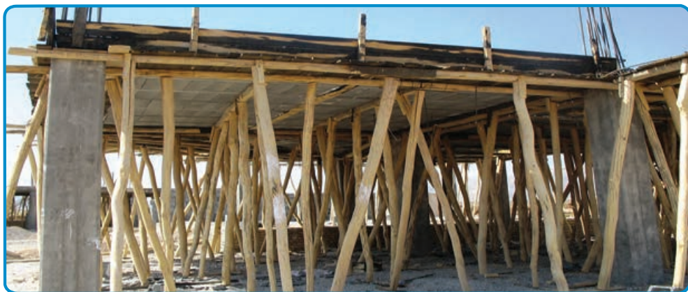
شکل ۳-۲۴- استفاده از شمع‌های چوبی جهت نگهداری قالب‌ها
