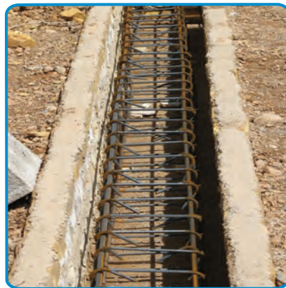
شکل ۵-۷- اجرای میلگرد شناژها
