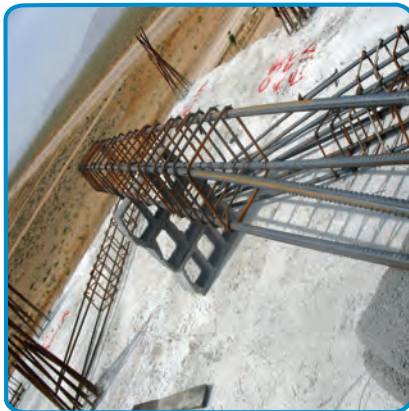
شکل ۷-۲۲- آماده کردن میلگردهای تیر روی زمین
