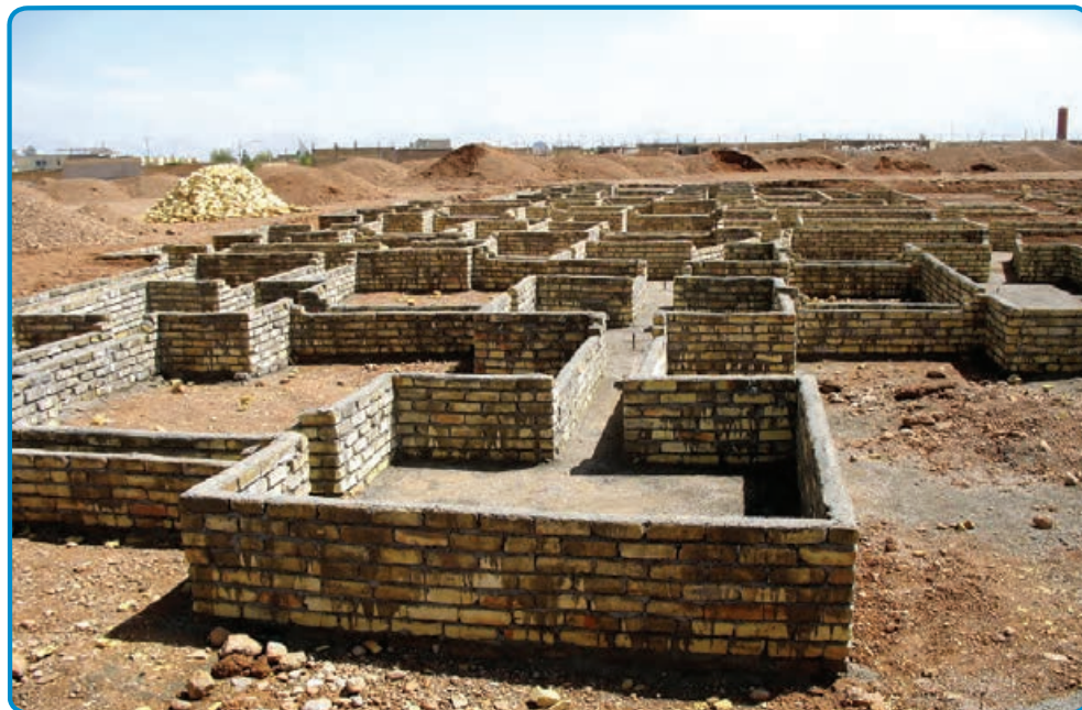
شکل ۱۵-۳- استفاده از قالب آجری برای اجرای پی
