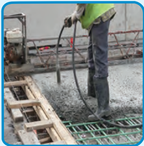
شکل ۱۴-۳- ویراتور یا لرزاننده بتن داخل قالب
