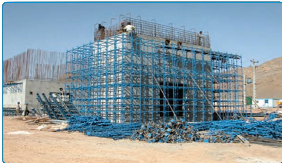
شکل ۳-۲۶- داربست فلزی
