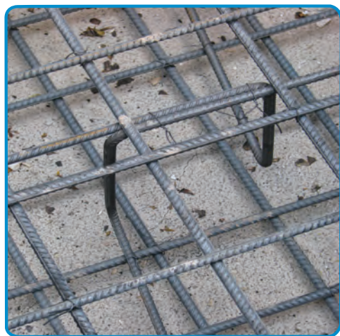
شکل ۳-۵۳- استفاده از خرک در میلگرد گذاری پی
