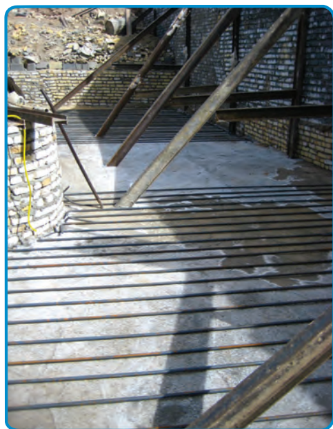
شکل ۳-۴۶- میلگرد طولی کف پی
