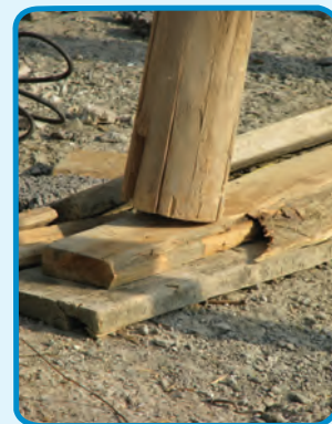
شکل ۳-۲۵- استفاده از گُوه جهت تنظیم ارتفاع
