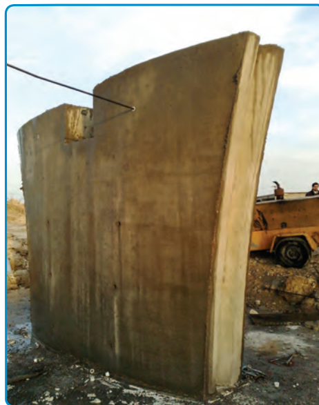
شکل ۳-۴۲- قالب برداری
