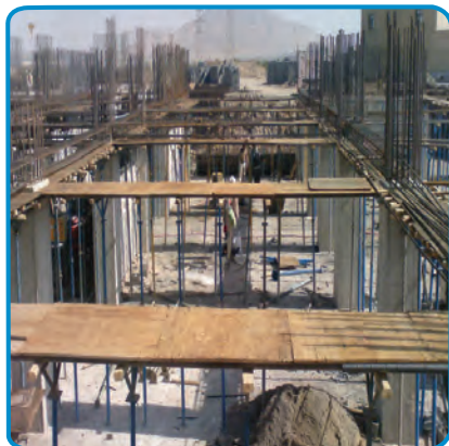
شکل ۷-۲۱- قالب بندی تیرها
