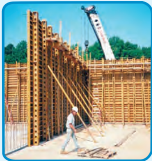
شکل ۱۹-۳- فایبر گلاس برای اجرای دیوار بتنی
