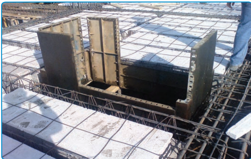
شکل ۳۵-۷- تکمیل قالب بندی
