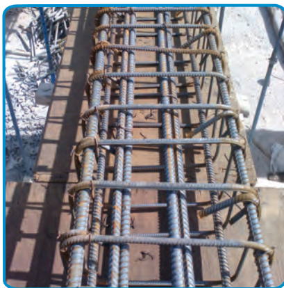
شکل ۷-۲۵- بستن خاموت ها با مفتول
