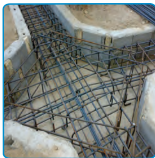
شکل ۱۴-۷- تکمیل میلگردگذاری محل اتصال ستون
