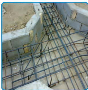
شکل ۱۳-۷- قرار دادن میلگردهای تقویتی پخ‌ها
