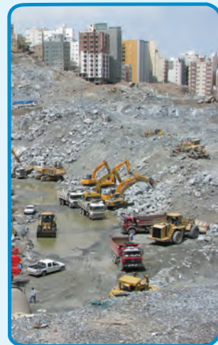
شکل ۳-۷- گودبرداری در زمین‌های نامحدود
