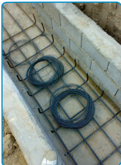
شکل ۷-۹- بهم بستن میلگردها
