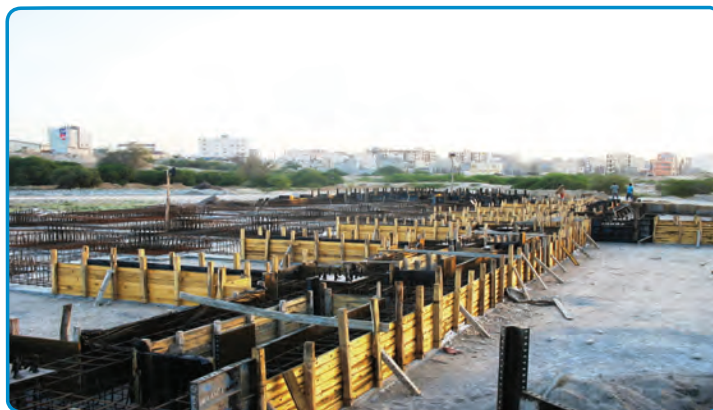
شکل ۳-۲۷- قالب چوبی برای اجرای پی
