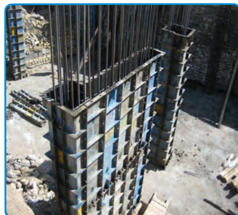
شکل ۳-۳۵- قالب فلزی برای اجرای دیوار بتنی
