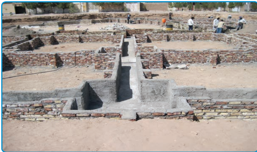
شکل ۳-۲۹- قالب آجری برای اجرای پی
