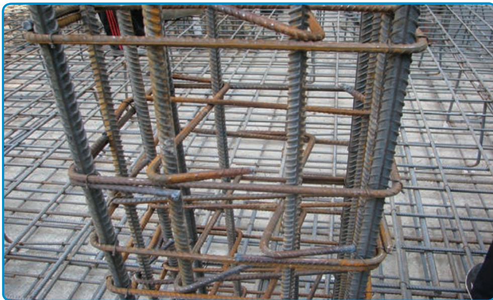
شکل ۵۰-۳- کاربرد سنجاقک در میلگرد گذاری ستون
