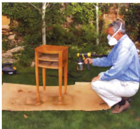
شکل ۴-۲۳. رنگ‌کاری با پیستوله (رنگ پوششی).
