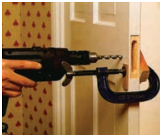
شکل ۱۰-۴۸- سوراخ‌کاری ممل پلاک و دستگیره‌ی قفل.
