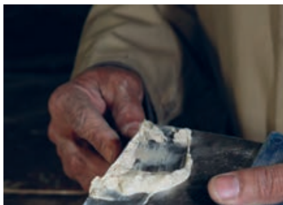
شکل ۴-۱۵- هر بار باید مقدار کمی بتونه روی لیسه قرار داد.
