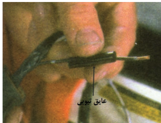
شکل ۶۳-۶- وارد کردن سیم به داخل عایق تیوبی
