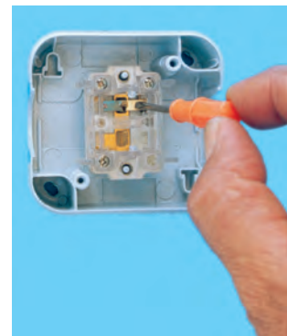
ج - برقراری اتصال پلاتین با کنتاكت غیر مشترک ۱
