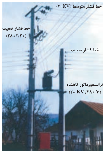
شکل ۲۷- خطوط فشاری متوسط و ضعیف هوایی برق
