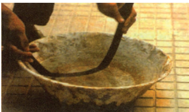
شکل ۴-۴۵ - سرد کردن لوله پس از خم‌کاری
