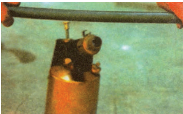
شکل ۴-۴۳ - حرارت دادن لوله‌ی PVC
