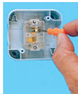
ج - برقراری اتصال پلاتین با کنتاكت غیر مشترک ۱
