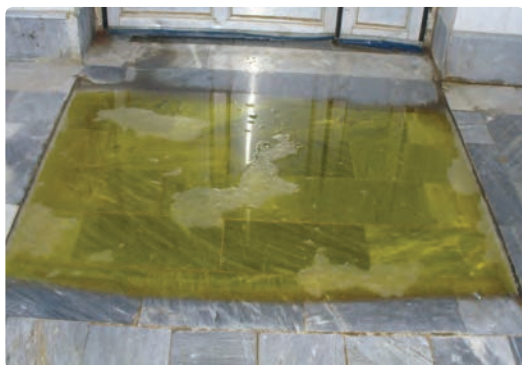
شکل ۱۱- تعبیه حوضچه ضد عفونی در مدخل سالن مرغداری
