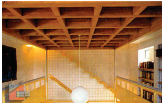
◀ شکل ۱-۵۹- سقف کاذب مشبک چوبی
