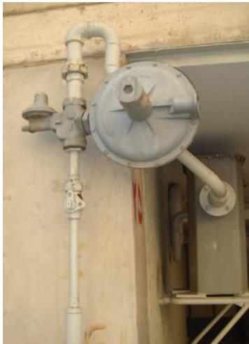
▲ شکل ۲-۹۳ علمک و رگولاتور روی آن
