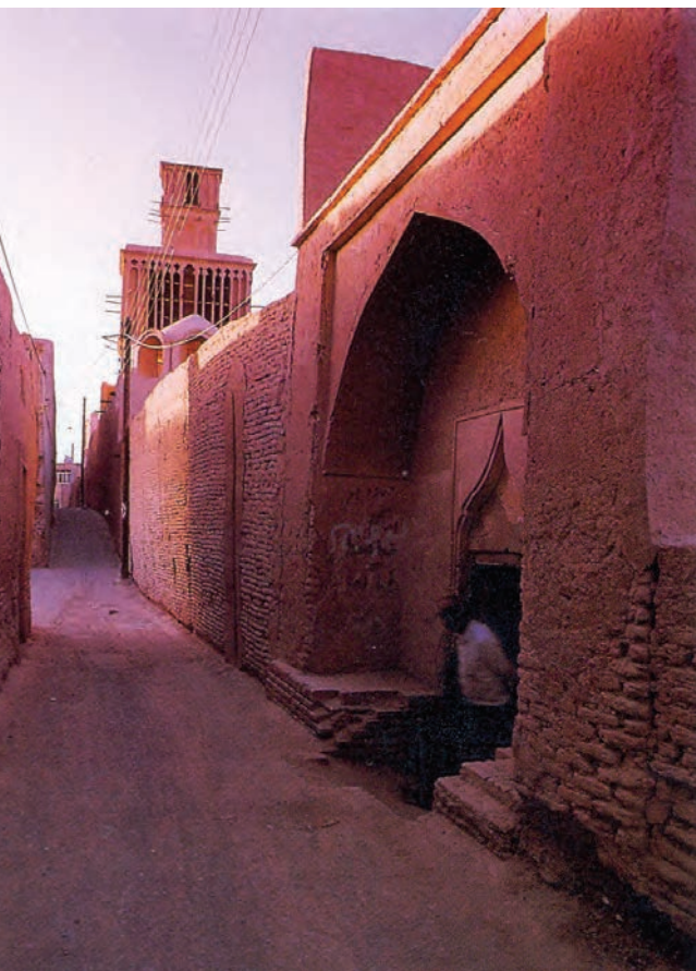
تصویر ۹-۵- نمای بیرونی فاقد پنجره
