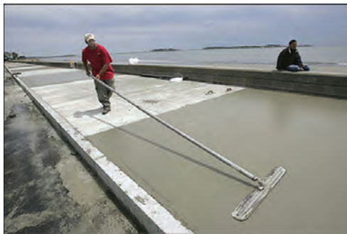
❖ شکل ۳-۵۵ رویه نهایی معابر با بتن درجا
