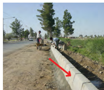
▲ شکل ۳-۳۱ جدول مانع عبور با شیب داخلی
