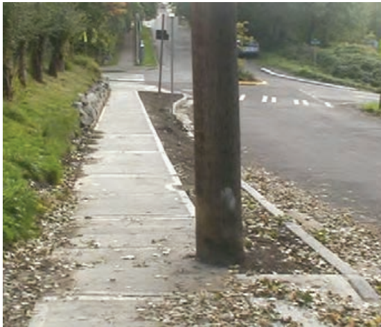
▲ شکل ۳-۴۰ به کارگیری قطعات مجزا در کفسازی
