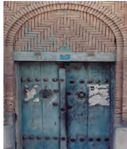
▲ شکل ۴-۷ کاربرد قوس در نعل درگاه
