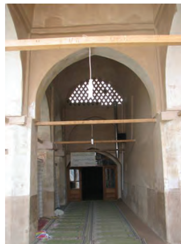
▲ شکل ۴-۷۲ کاربرد چوب در ساخت قوس‌ها
